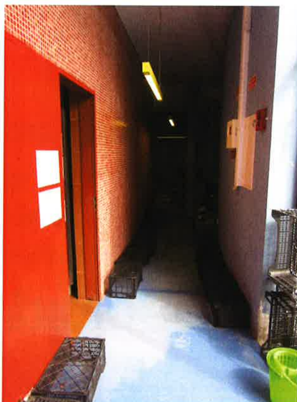
Edifício de refeitório (interior) – área a encerrar com parede divisória e mobiliário de apoio
