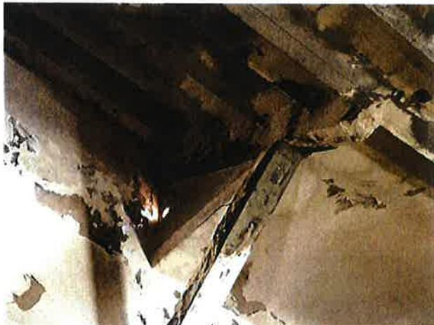
Observação das bancadas pela sua zona inferior, sendo evidente a existência de reparações, à base de gesso, que se traduzem ineficazes e indicando um estado de manutenção de Mau.
