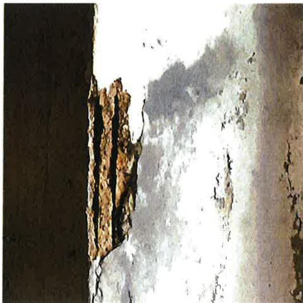
Elemento de pilar com armaduras expostas, sendo evidente o estado de corrosão avançado das armaduras e perda de secção do aço.
