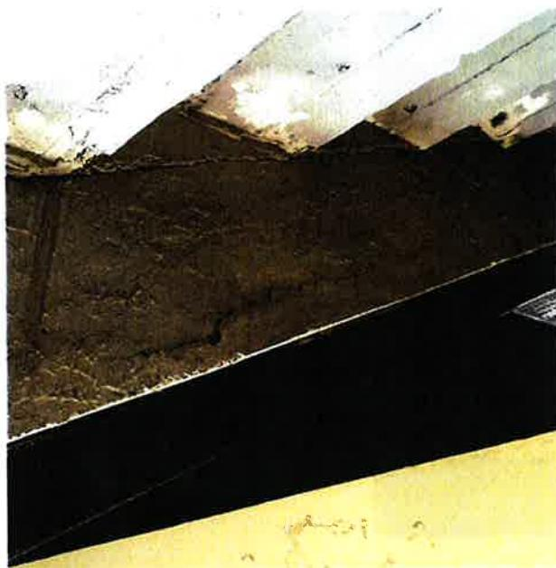
As vigas de apoio à bancada têm fendas graves, estando reforçadas com perfis metálicos.
