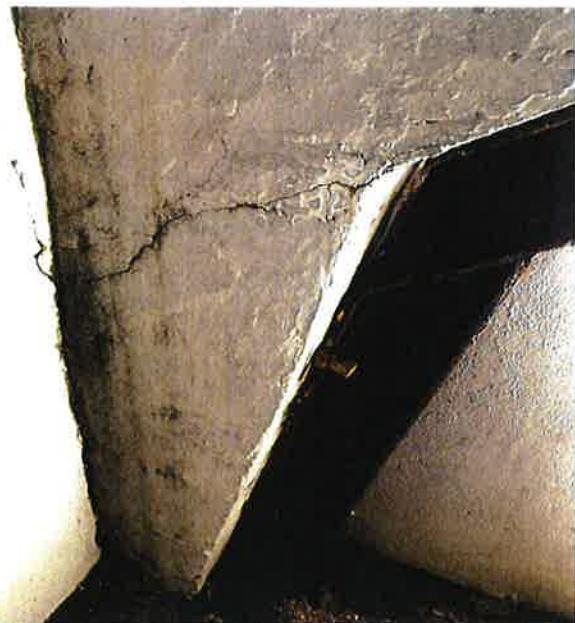
Pilar reforçado com estrutura metálica, podendo observar-se a fratura na secção de betão armado, o que fundamenta o estado de EC5 atribuído.
