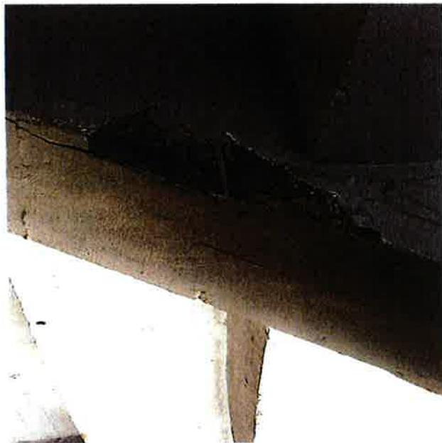
Delaminação do betão, sendo visível o destacamento físico entre o betão e as armaduras.
