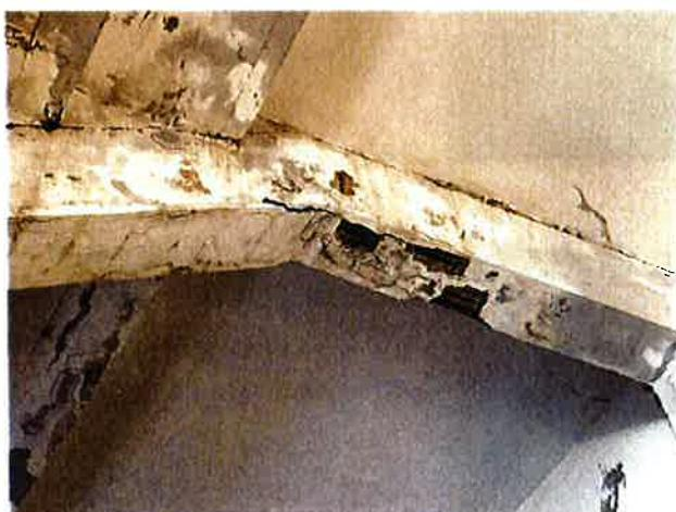
Delaminação do betão com destacamento físico entre o betão e a armadura.
