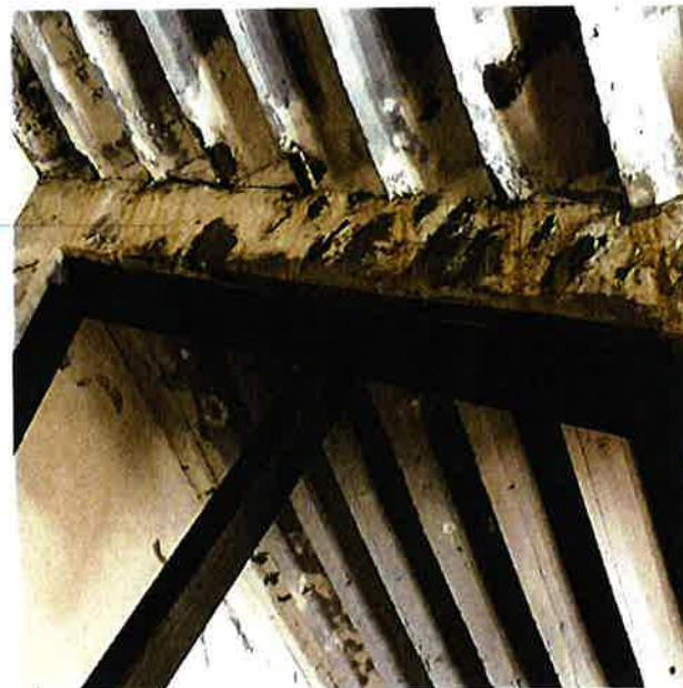
Vigas reforçadas com estrutura metálica, podendo observar-se a debilitada ligação das bancadas à viga, assim como as armaduras em estado de corrosão avançado.
