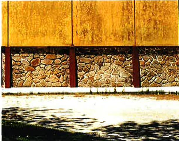
Os muros são construídos em alvenaria de granito com junta refechada.
