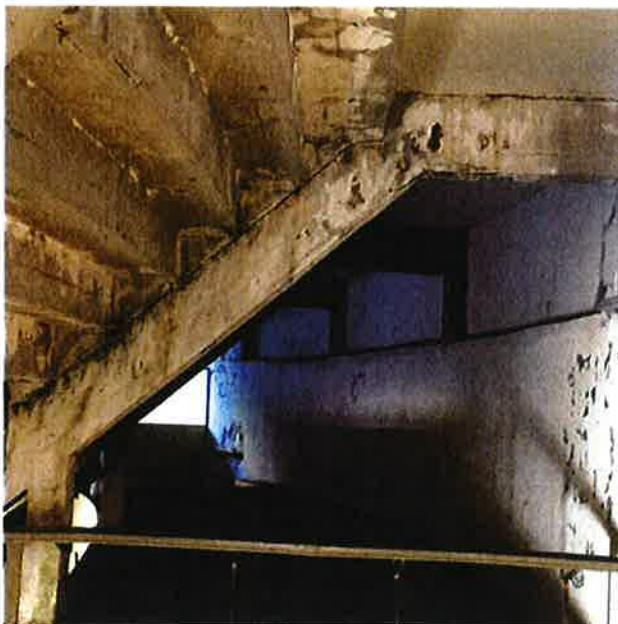
Zona das bancadas no apoio às vigas, observando-se reparações da bancadas ineficientes, e dessolidarização destas às vigas.
