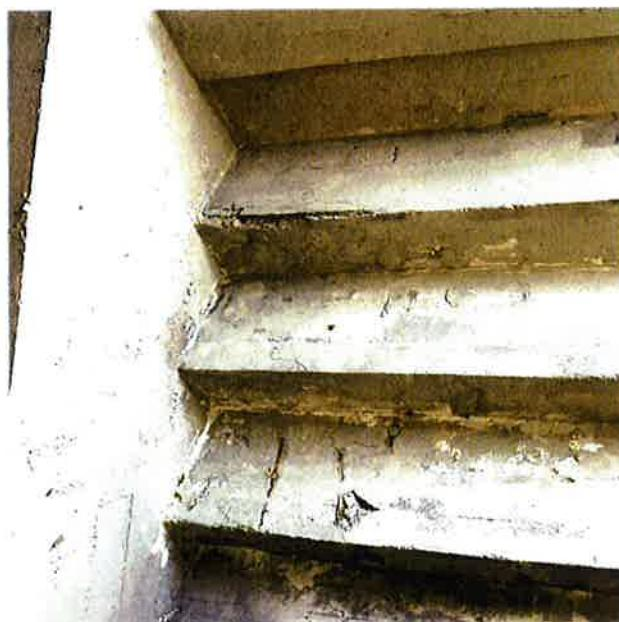
Fissuração e fendas em escadas de acesso à bancada.
